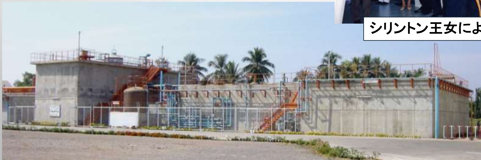
高効率嫌気性廃水処理(UASB)モデルプラント
